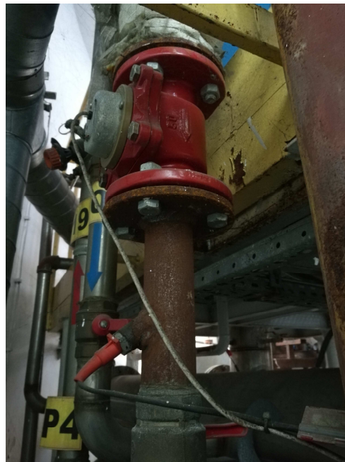
Rys.3 – Istniejące przepływomierze oraz czujniki temperatury
